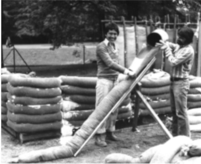
Figura 1. Muro de manguetas textiles rellenas de tierra. Fuente Gernot Minke 2001
