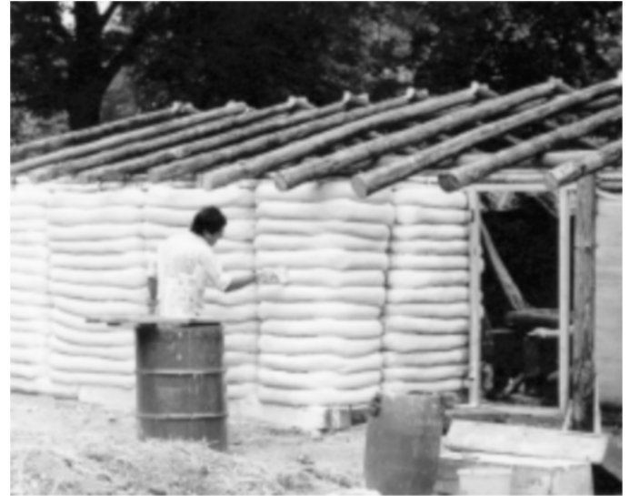
Figura 1. Muro de manguetas textiles rellenas de tierra. Fuente Gernot Minke 2001
