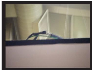
Figura 6. Cableado mal colocado sobre cubículo anexo a talleres
