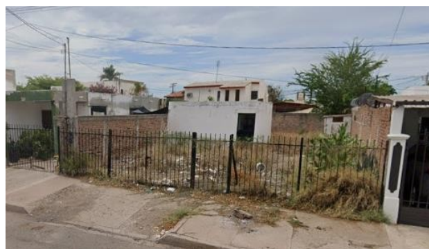
Figura 2. Estado deplorable en la banqueta en la C. Mariano Escobedo.
